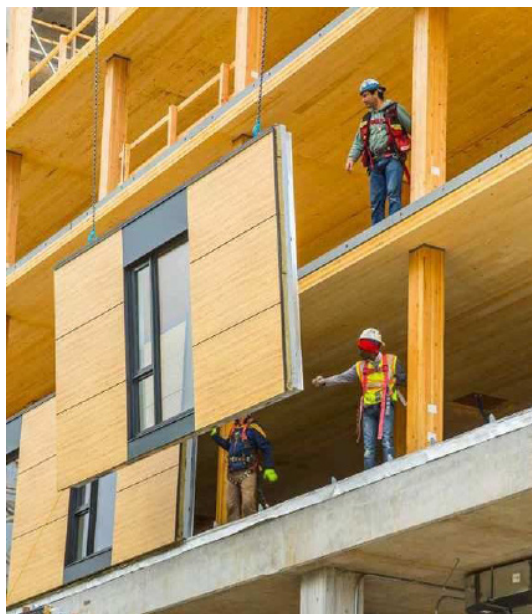
Los sistemas de madera en seco ganan mucho tiempo en su construcción, lo que repercute en los costes financieros de la promoción. Residencia universitaria Brock Commons (Vancouver, Canadá)
