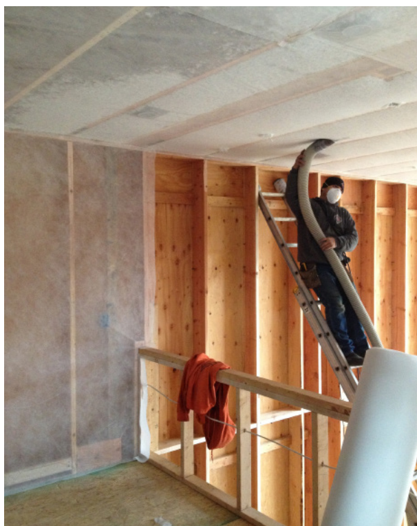
Sistema Advanced Framing, de 2 x 6” que permite mayores aislamientos
